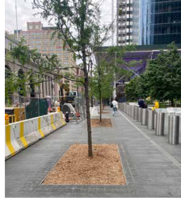
Figura 30: Árbol al cual se le levantó la copa para permitir la circulación peatonal por debajo.
