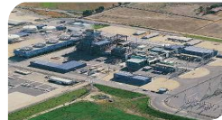
San Isidro II 248 MW Chile
