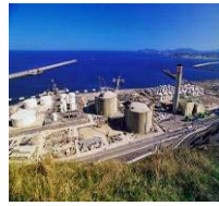
LNG Plant 9.5 million m3/d Chile (Fast-track)
