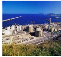
LNG Plant 9.5 million m3/d Chile (Fast-track)
