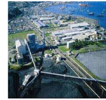
Bocamina II 370 MW Chile
