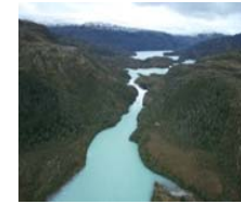
HidroAysén 2,750 MW Chile
