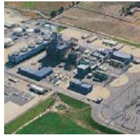
San Isidro II 105 MW Chile
