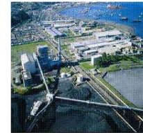
Bocamina II 370 MW Chile
