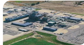
San Isidro II 248 MW Chile
