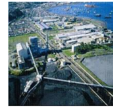
Bocamina II 350 MW Chile
