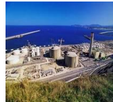
LNG Plant 9.5 million m3/d Chile (Fast-track)
