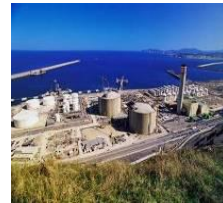
LNG Plant 9.5 million m3/d Chile (Fast-track)
