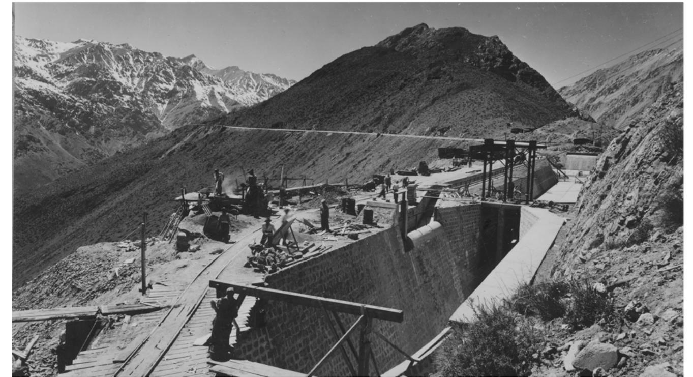
Fig 63. Cámara de carga de la central hidroeléctrica Los Molles, ca.1950.
